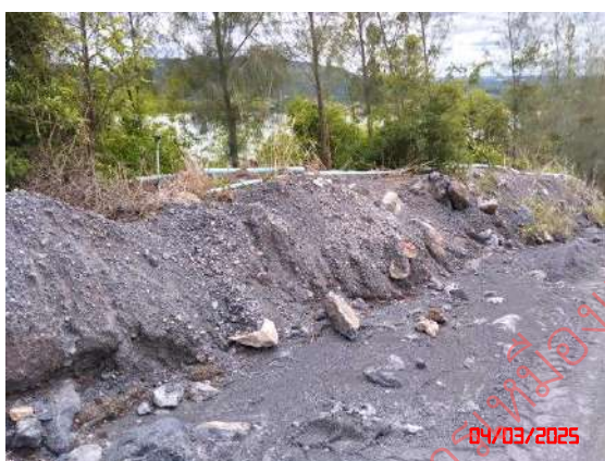
รูปที่ 15 คันทันดิน และคูระบายน้ำ
