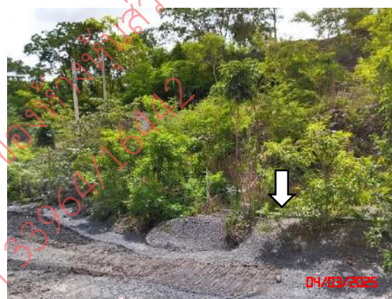
รูปที่ 15 คันทันดิน และคูระบายน้ำ
