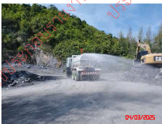
รูปที่ 8 การฉีดพรมน้ำบริเวณพื้นที่โครงการ
